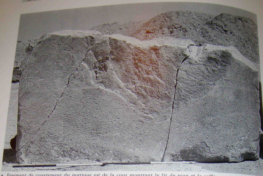
a. Fragment de couvrent du portique est de la cour montrant le lit de pose et le soffite.
